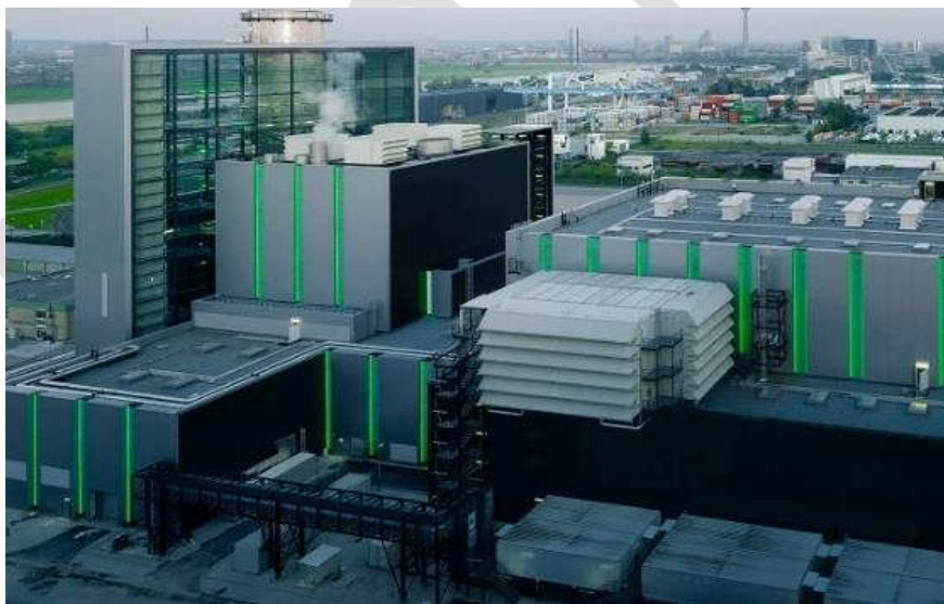
Рис.4.3. Вид на КБОУ компании FAIST AIS для ГТУ SGT5-8000H энергоблока «Фортуна» электростанции Kraftwerk Lausward в Дюссельдорфе [4]
