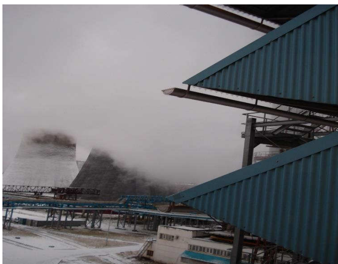
Рис.2.46. Пар от вентиляторной градирни на всасе КВОУ ГТУ
