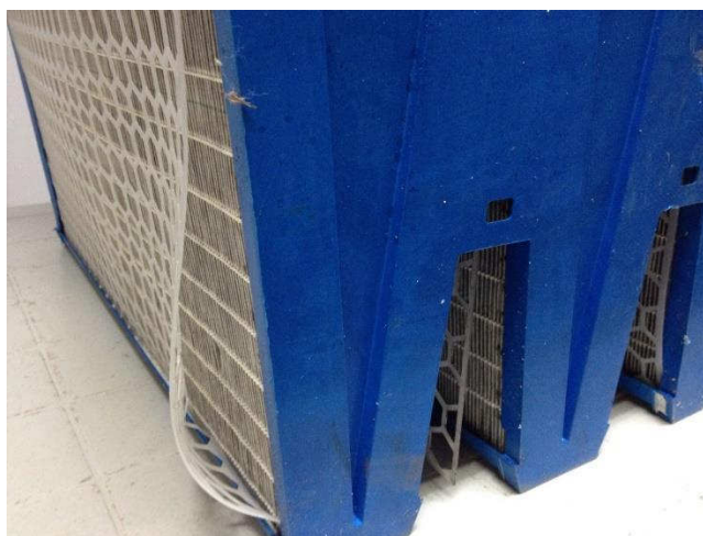
Рис.3.84. Ненадежно закрепленная защитная синтетическая решетка
