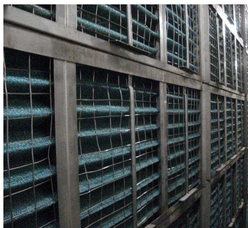
Рис.2.63. Неправильная установка фильтров в КВОУ ГТУ
