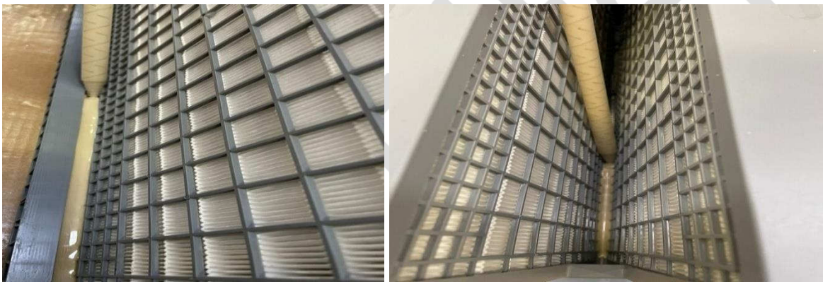
Рис.4.49. Герметизация стыков в V-образных секциях кассетных фильтров: а – с одной стороны; б- с двух сторон
