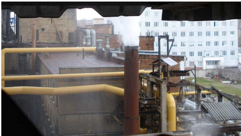
Рис. 2.44. Пар из барбатера перед всасом КВОУ ГТУ
