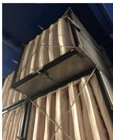
Рис. 4.13. Бокс для установки фильтров средней и тонкой очистки воздуха и также датчиков давления
