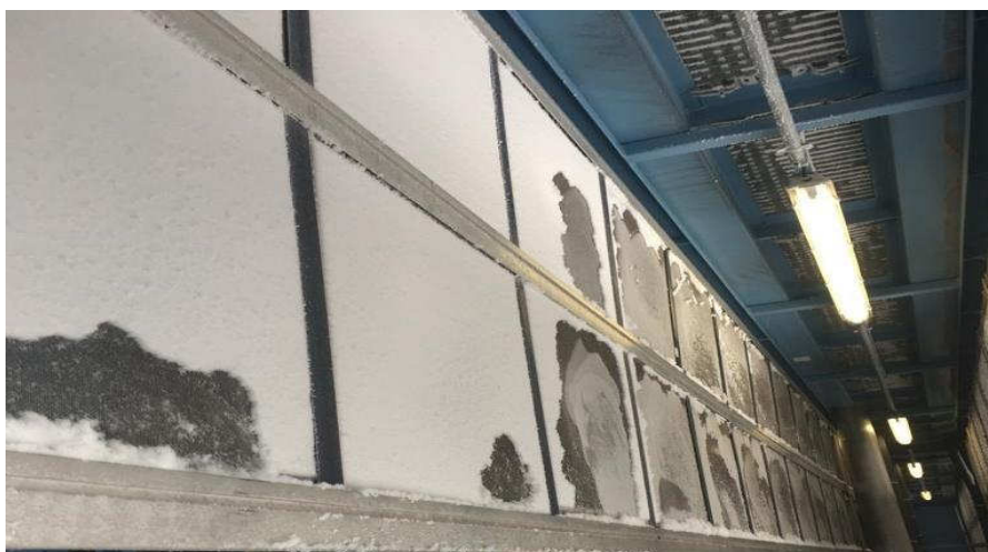
Рис.2.61. Не снятые с КВОУ ГТУ противомоскитные сетки на зиму
