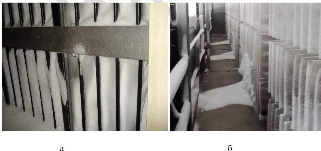
Рис.3.64. Установка карманных фильтров: а- базовая; б- реверсная
