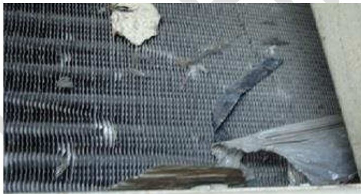
Рис.2.35. Теплообменный аппарат КВОУ ГТУ с мусором
