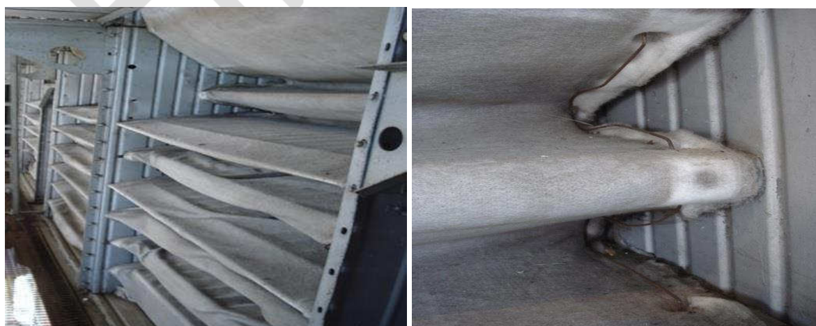
Рис.И3. Система фильтрации: а- внешний вид; б- способ крепления фильтровального материала
