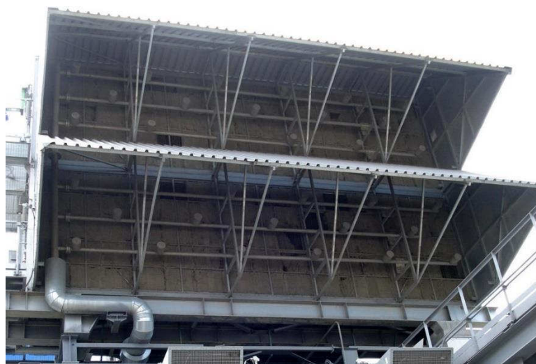
Рис.2.52. Расположение форсунок распыла системы антиайсинга на КВОУ ГТУ
