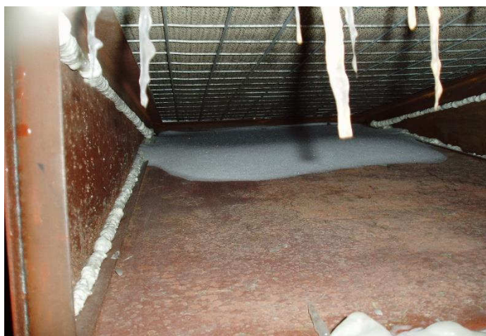
Рис.2.50. Снег и лед в фильтре первой ступени КВОУ ГТУ ТЭЦ г. Тюмень
