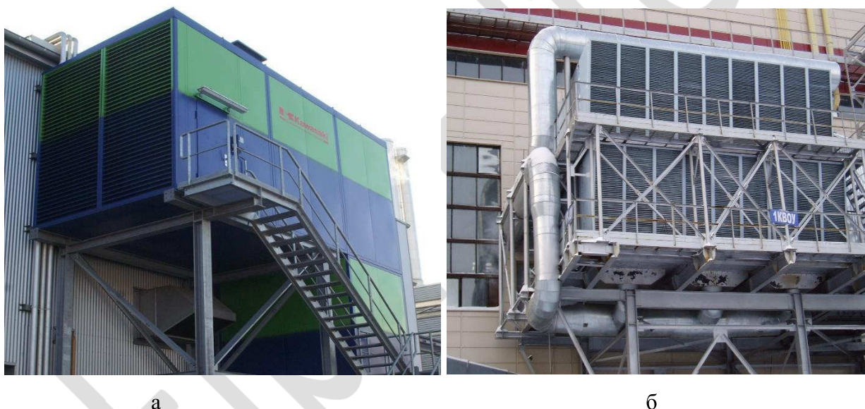
Рис.2.49. КВОУ ГТУ без погодных козырьков: а- в Кайзерслаутерне; б- в Тюмени.
