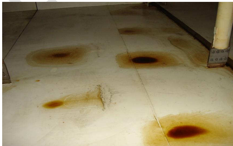
Рис.2.66. Маслянистые отложения на чистой стороне КВОУ ГТУ
