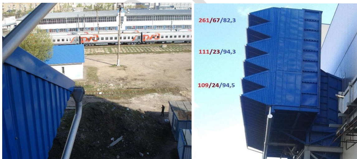
Рис.2.47. Всас КВОУ ГТУ: а - ориентирован на железнодорожный вокзал; б- результаты замеров загрязненности воздуха по высоте КВОУ.
