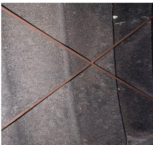
Рис.2.62. Крепление фильтров в КВОУ ржавыми фиксаторами: а- фильтр грубой очистки; б- фильтр тонко очистки класса Е11
