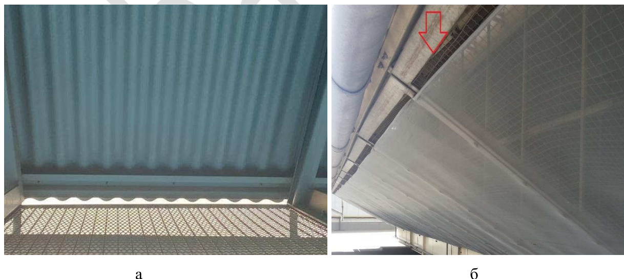
Рис.2.48. Защитные сетки: а- от птиц и мусора; б- противомоскитная сетка
