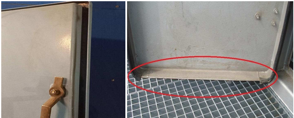
Рис.2.64. Отсутствие герметичности дверей КВОУ: а- уплотнение отсутствует; б- отсутствует часть уплотнения.
