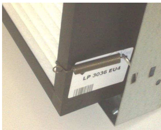
Рис.3.32. Механизм крепления ФГО в КСФ финской компании AF с помощью пружины.
