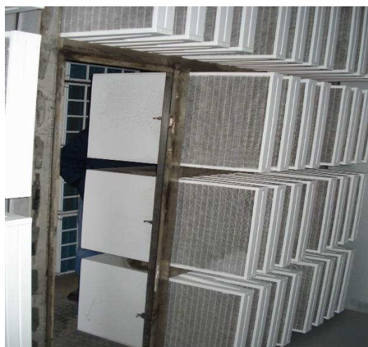
Рис.3.20. Раздельная установка фильтра коагулятора и КСФ
